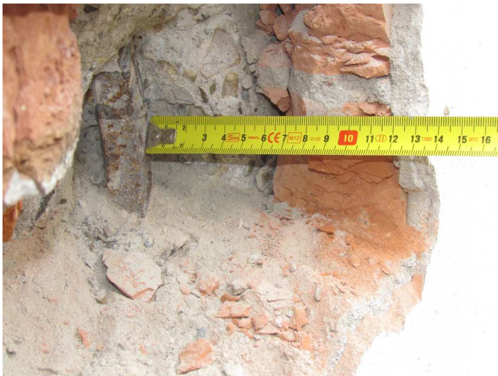
Odkrywka nr 3 - zbrojenie słupa w hali C od zewnątrz
