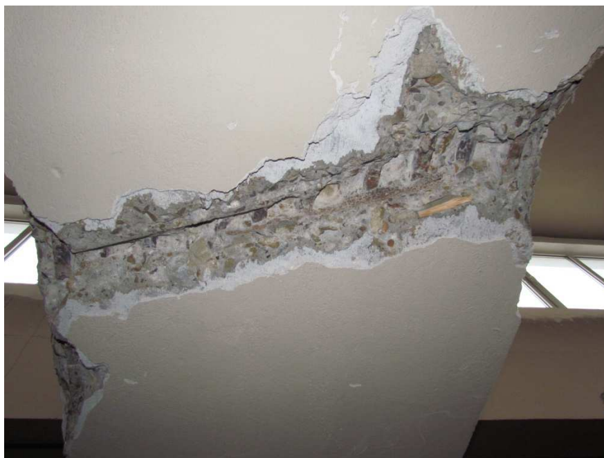
Odkrywka nr 16 - zbrojenie rygla w hali D
