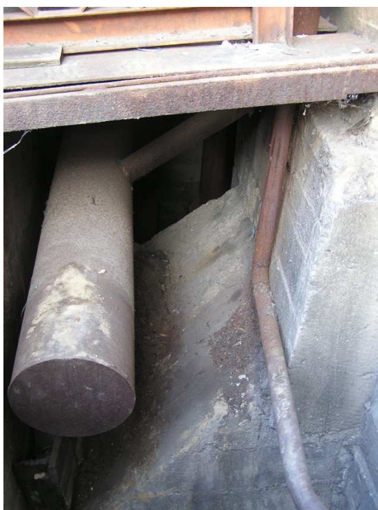
Fundament pod słup ramy w osi c.7 w hali C (od strony podwórza)
