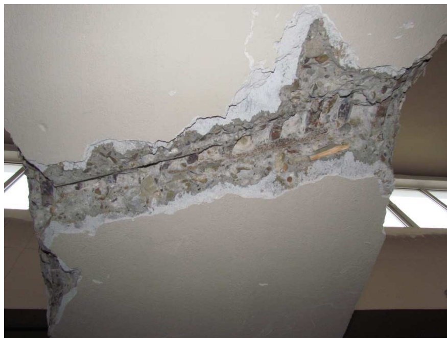
Odkrywka nr 16 - zbrojenie rygla w hali D
