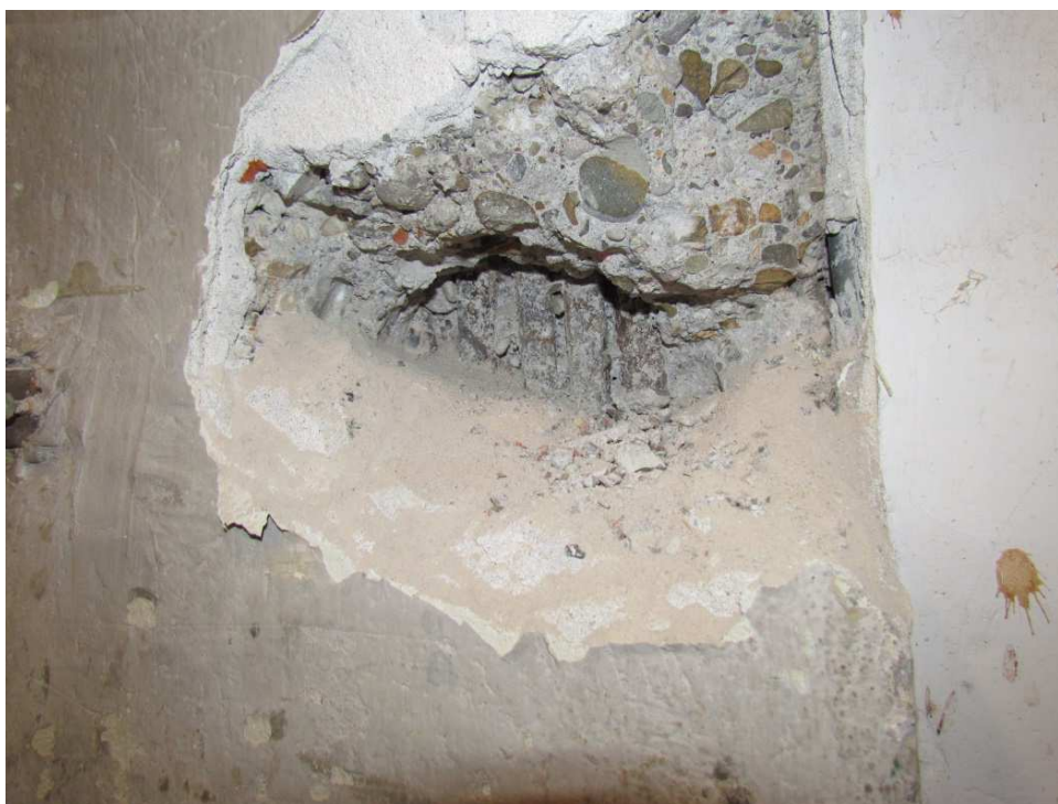
Odkrywka nr 5 - zbrojenie słupa w hali D w osiach O – d8
