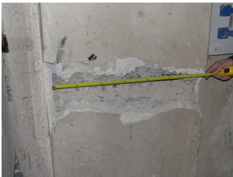
Odkrywka nr 2 - zbrojenie słupa w hali C
