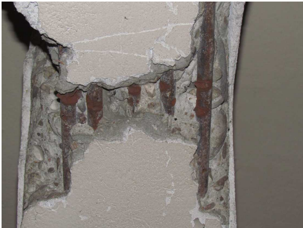
Odkrywka nr 15 - zbrojenie belki stropodachu w hali D
