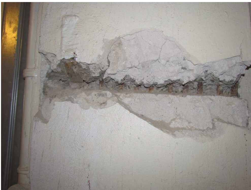
Odkrywka nr 6- zbrojenie słupa w hali D w osi S
