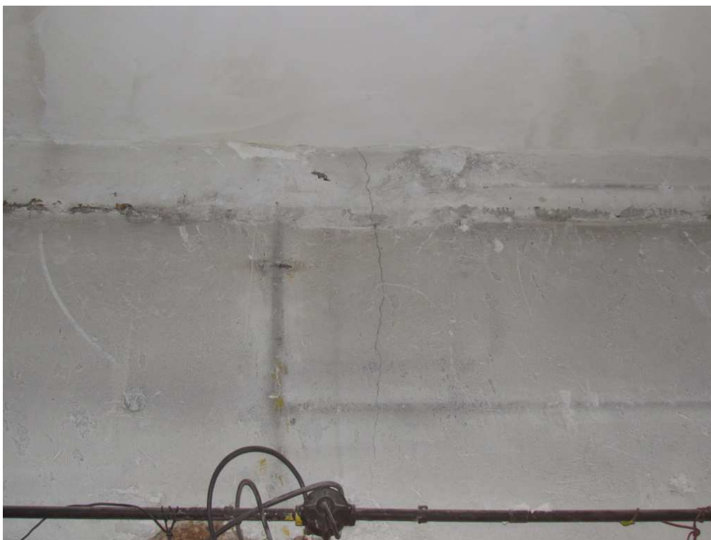
Zarysowanie podciągu j.w.
