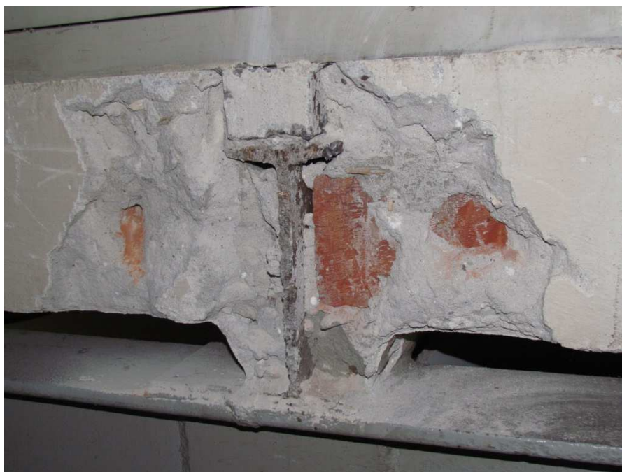
Odkrywka stropu nad lp. w hali C
