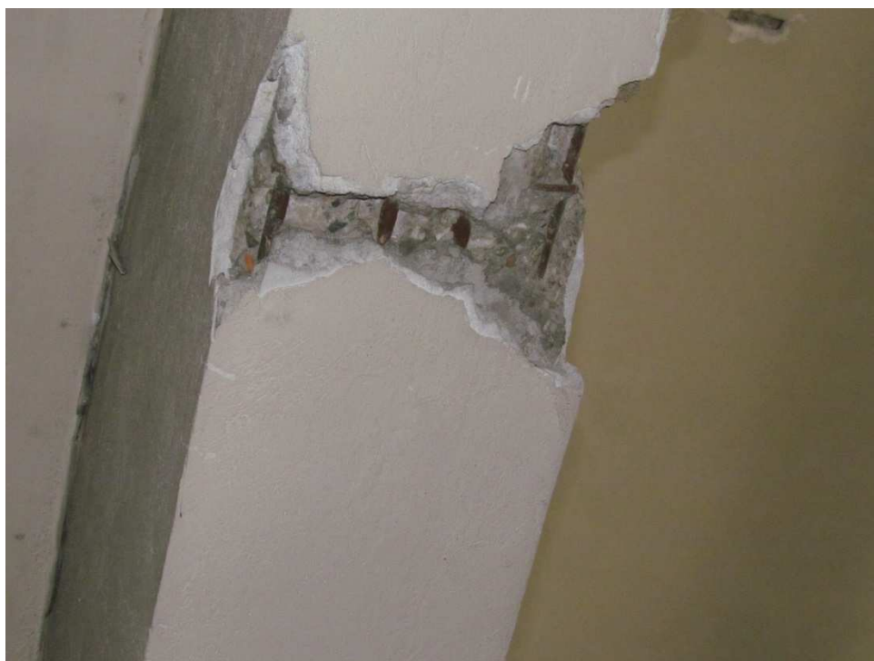
Odkrywka nr 14- zbrojenie podciągu stropodachu w hali C
