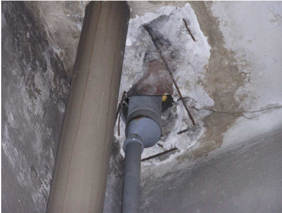
Odkrywanie zbrojenia płyty stropodachu w hali C
