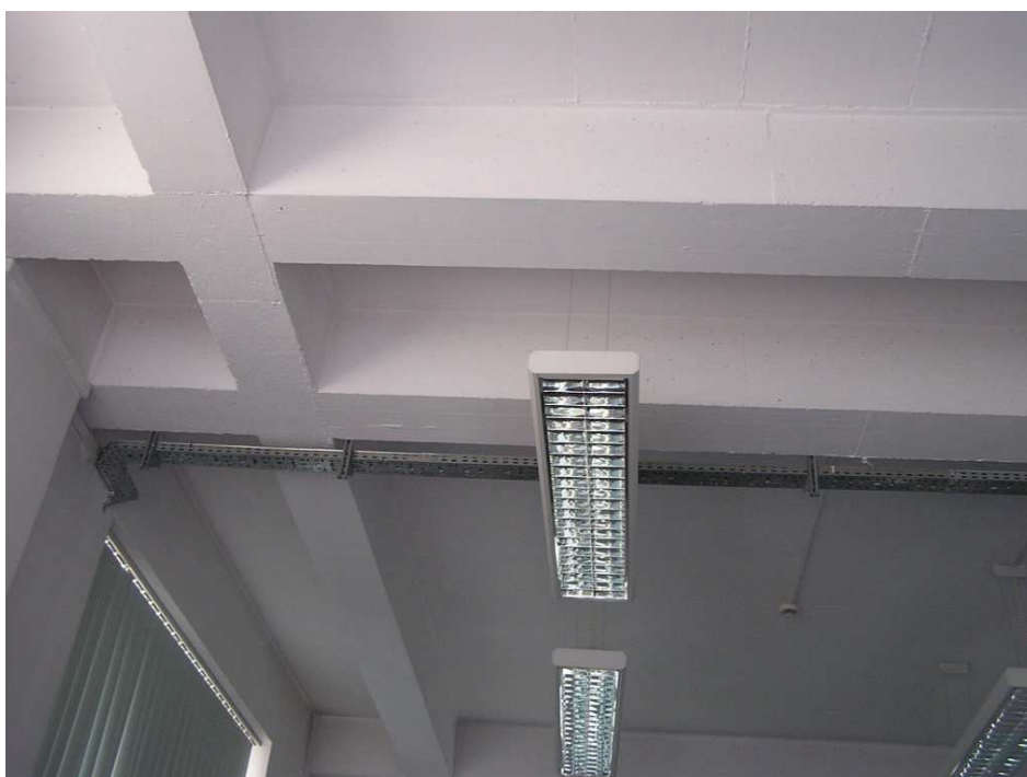
Żelbetowa konstrukcja stropu nad parterem w szczycie hali D
