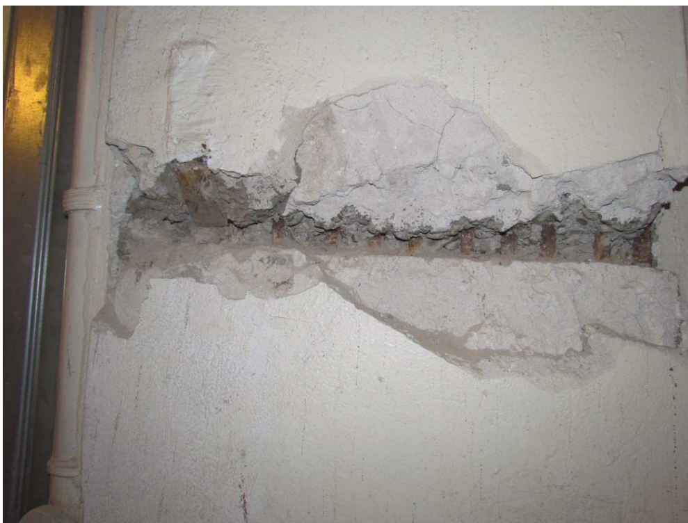
Odkrywka nr 6- zbrojenie słupa w hali D w osi S
