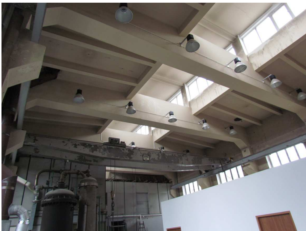
Konstrukcja ram żelbetowych w hali D
