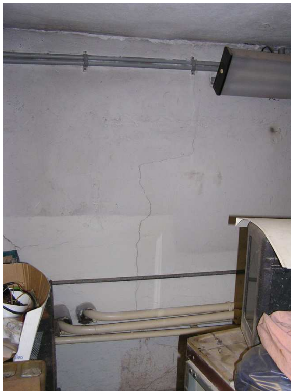
Rysa na zewnętrznej ścianie piwnic w pracowni RTG
