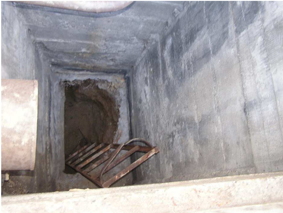
Fundament pod słup ramy w osi c.7 w hali C (od strony podwórza)– odkrywka
