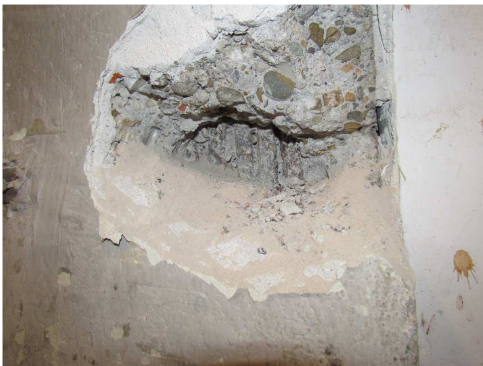
Odkrywka nr 5 - zbrojenie słupa w hali D w osiach O – d8
