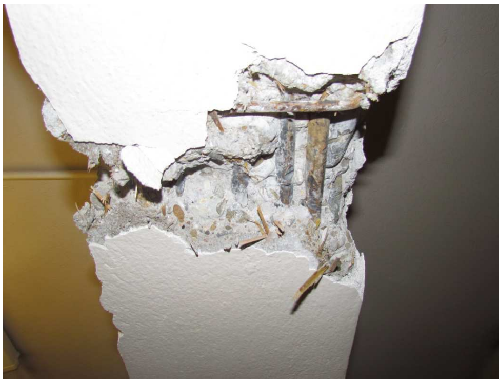
Odkrywka nr 11 - zbrojenie belki stropodachu w hali C
