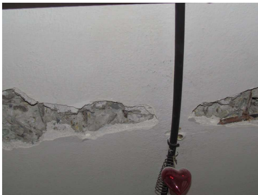
Odkrywka zbrojenia żebra stropodachu w hali C
