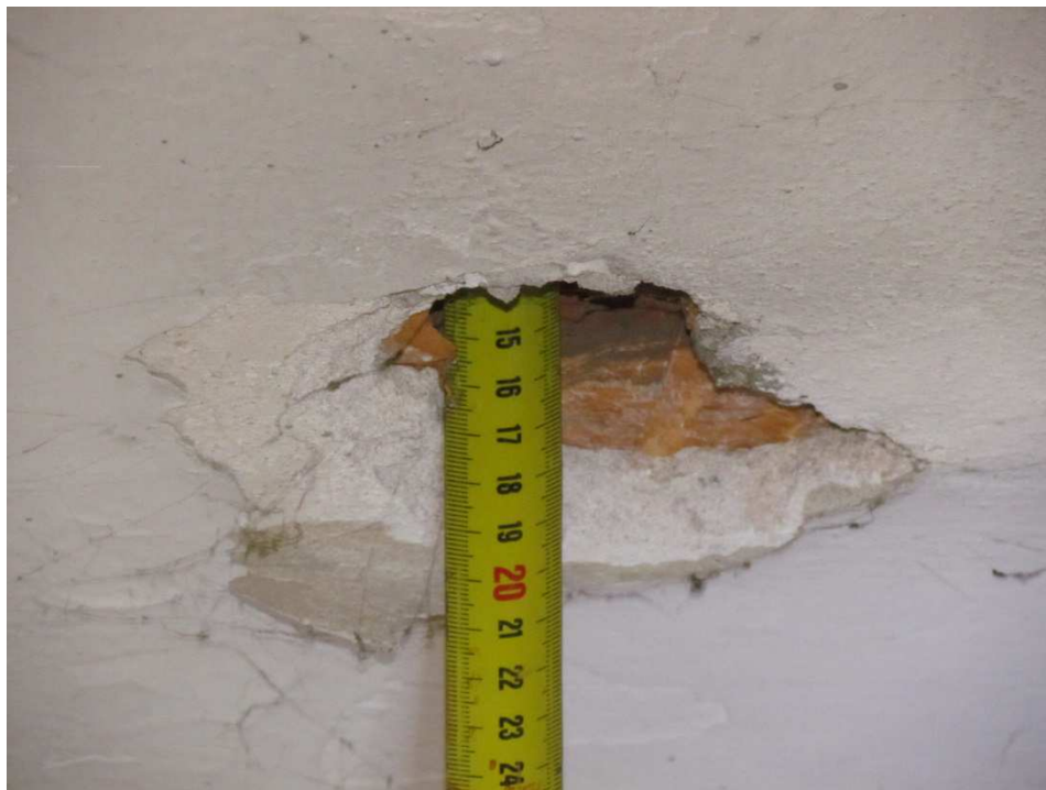
Odkrywanie stropu Akermana w przybudówce hali D
