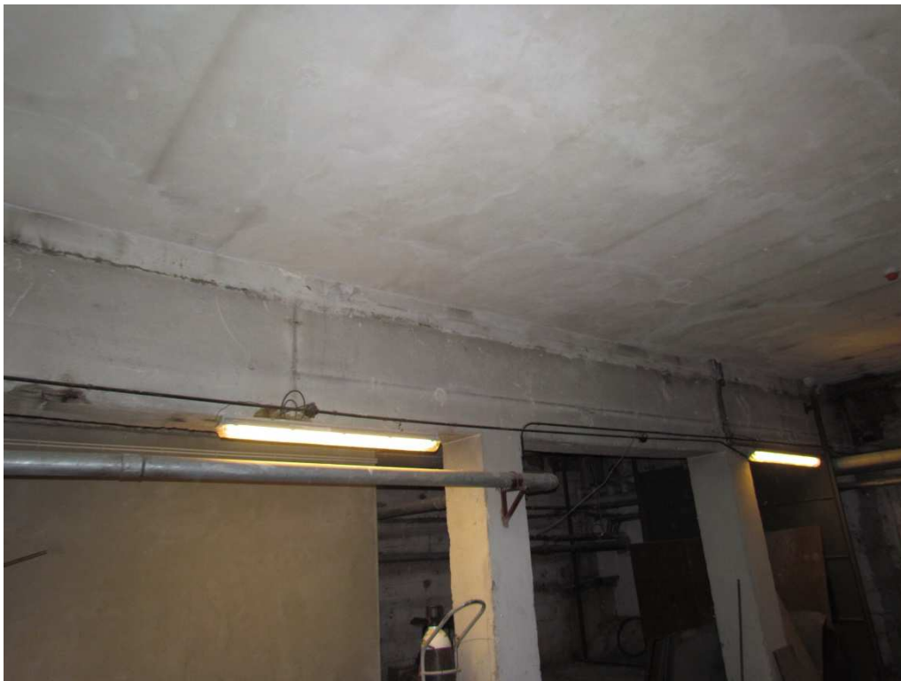
Żelbetowy podciąg ze słupami w piwnicy podtrzymujący ścianę wewnętrzną Auli
