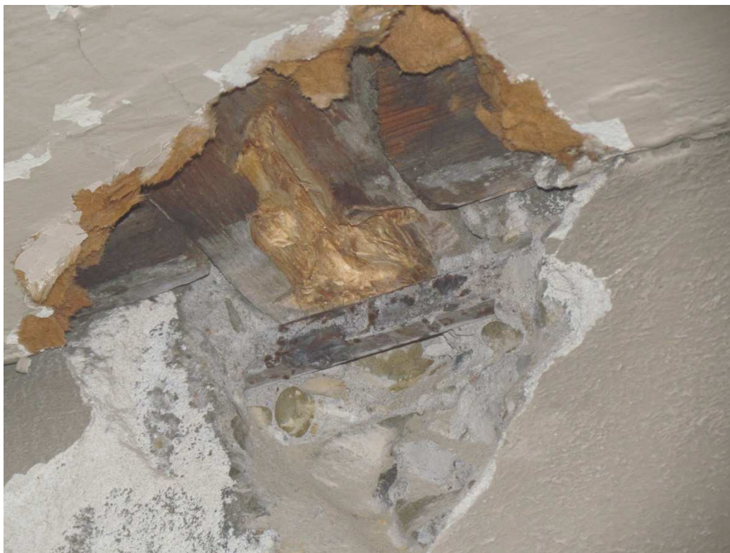
Drewniana konstrukcja dachu w dawnej kotłowni w hali D
