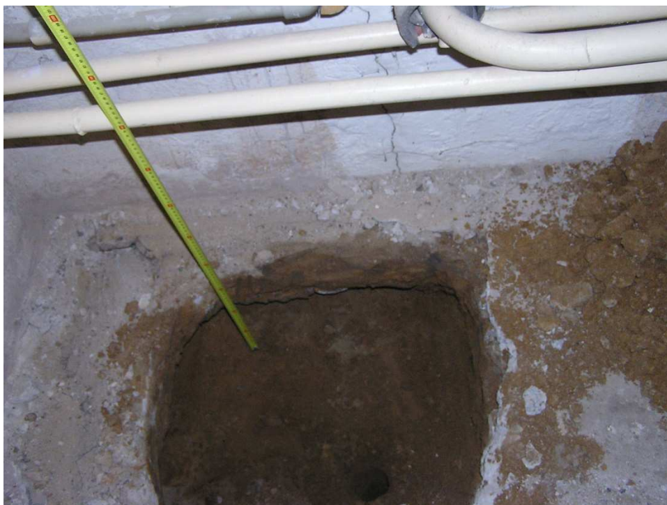
Odkrywka fundamentu pod ścianą zewnętrzną w pracowni RTG
