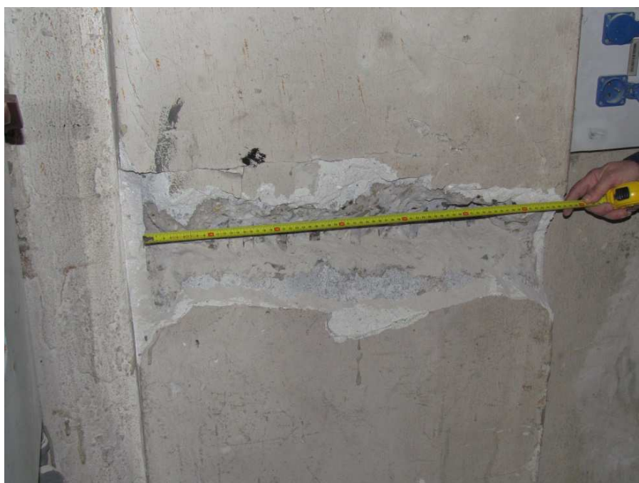
Odkrywka nr 2 - zbrojenie słupa w hali C
