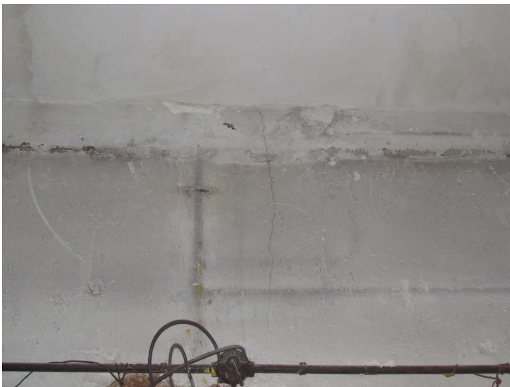
Zarysowanie podciągu j.w.
