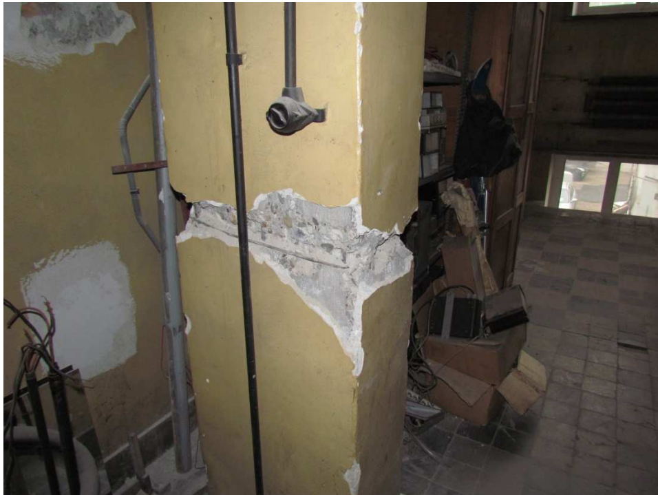
Odkrywka nr 8 - zbrojenie słupa w hali D na poziomie I p.
