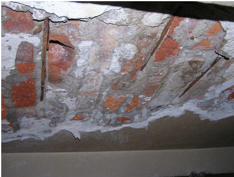
Odkrywka zbrojenia stropu Kleina w hali C
